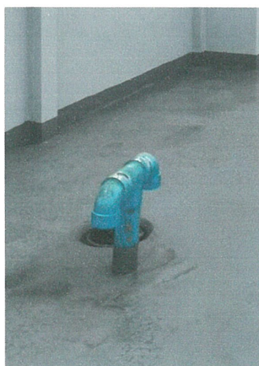
รูปภาพที่ 2.51 ท่อระบายก๊าซมีเทนจากบ่อเกรอะ
