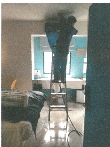
รูปภาพที่ 2.34 การล้างทำความสะอาดเครื่องปรับอากาศ
