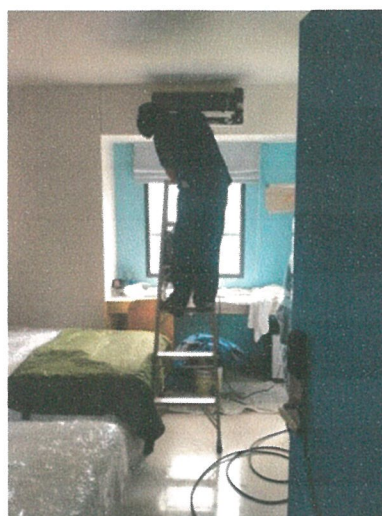
รูปภาพที่ 2.34 การล้างทำความสะอาดเครื่องปรับอากาศ
