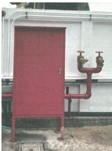
รูปภาพที่ 2.48 ตู้สายฉีดน้ำดับเพลิงและหัวจ่ายน้ำดับเพลิงบริเวณจุดจำหน่ายก๊าซฯ
